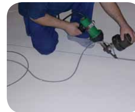
Longitudinal welding
